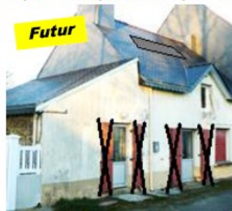
PROJET : Façade peinte en gris clair, volets supprimés, pose d'un panneau photovoltaïque encastré 3m x 1m
